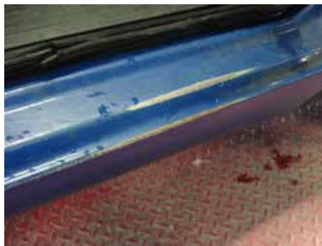
Niet acceptabel (roestvorming op en rond de beschadiging)
