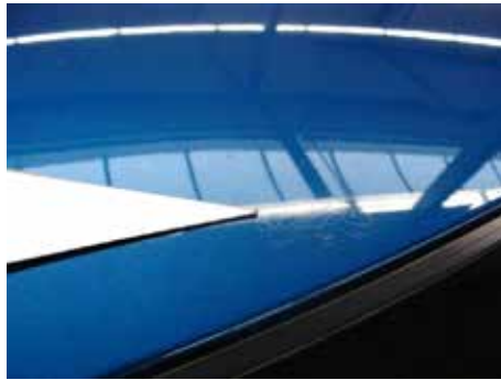
Niet acceptabel (vogelvuil; zichtbare aantasting)
